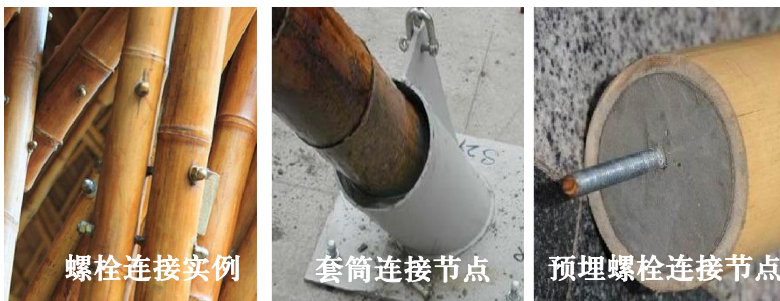
图 5.3-2 竹结构构件和构件间连接方式
