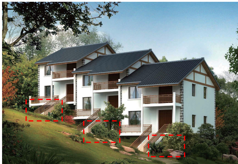
图6.3-3 架空层室外机植物遮挡
