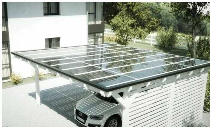
图6.1-1 光伏车棚实景
