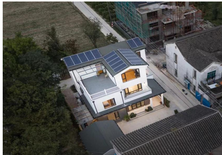
图6.1-5 坡屋面光伏安装实景
