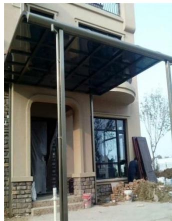
图2.4-3 雨棚遮阳实景
